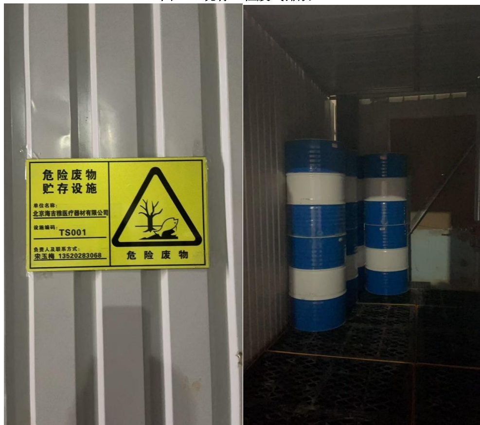
图 2-7 厂区现有危废暂存间
