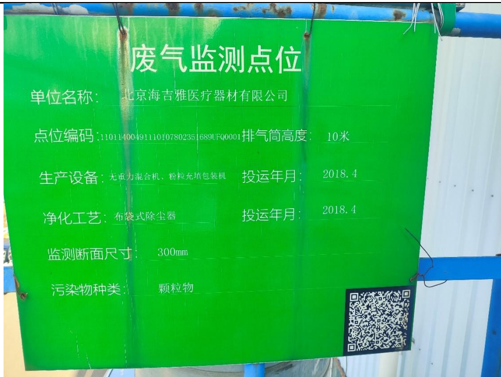
图 2-6 现有工程废气排放口
