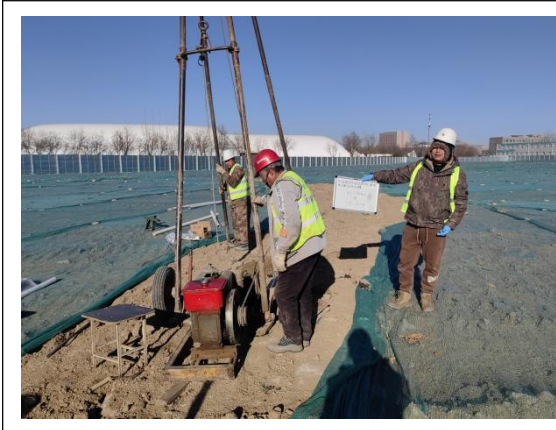
S14/MW3 钻探施工
