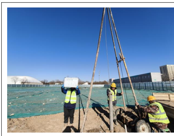
S2/MW1 钻探施工
