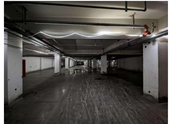
A-10 地块地下车库
