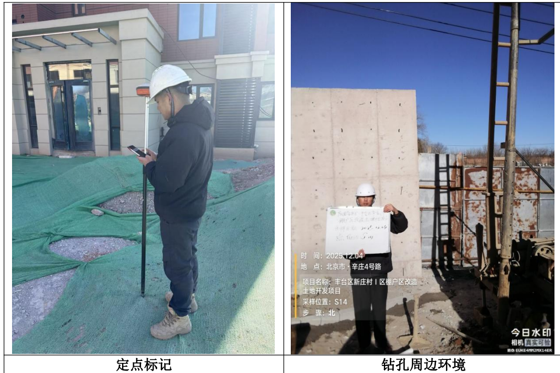
图 6.1-1 土孔钻探照片
