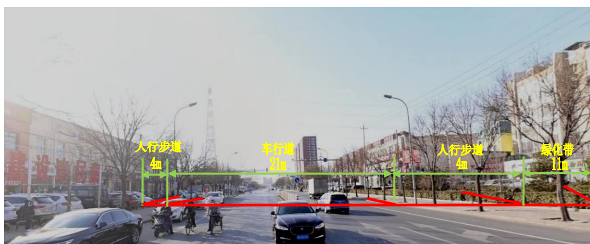
图 4 范家庄西路段至马家堡西路南延段段横断面实景图
