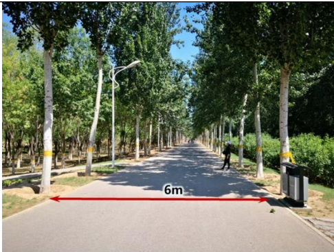
现状小清河东巡河路
