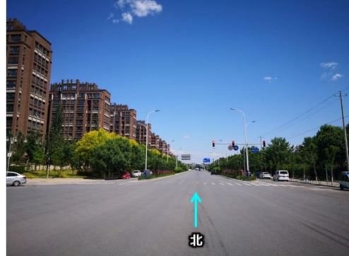
北 现状清苑北街北侧
