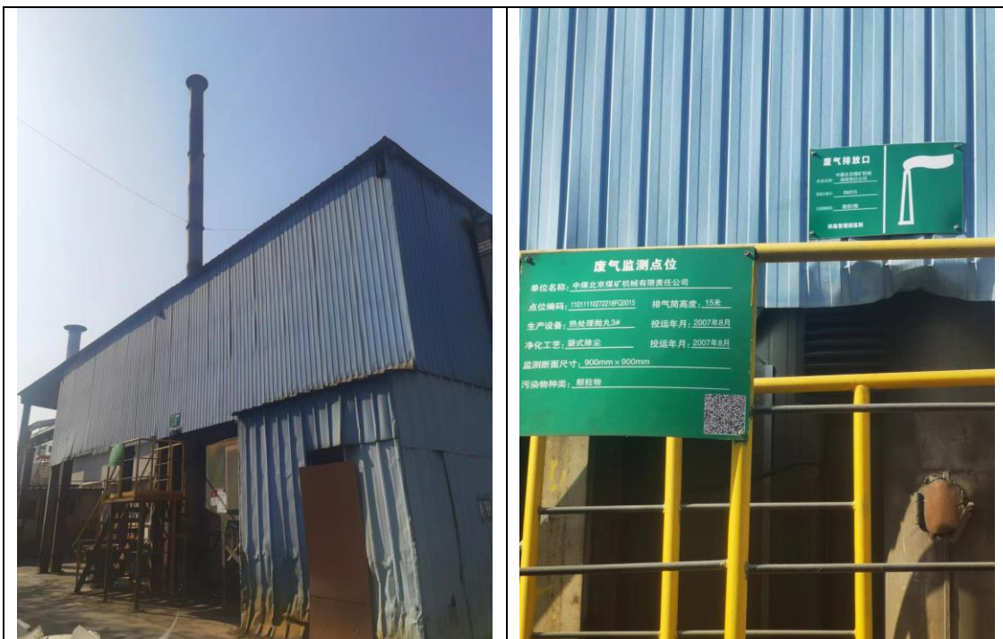
热处理抛丸 3#废气排口及标识牌照片
