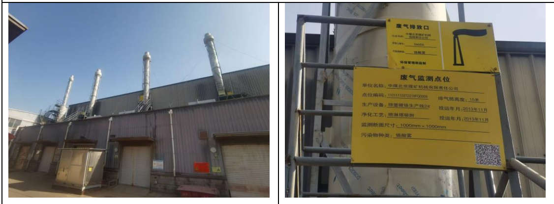
凯灵镀锌生产线废气排口及标识牌照片
