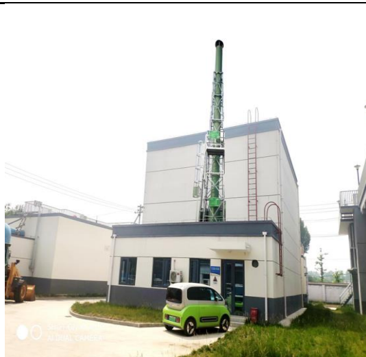
图 2-5 废气净化设施及排放口
