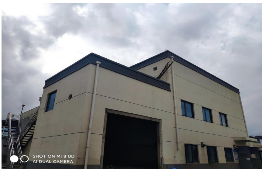
图 2-8 污泥脱水机房
