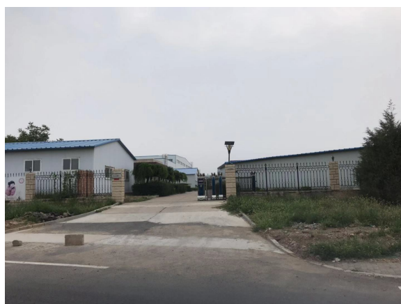
园区污水处理厂
